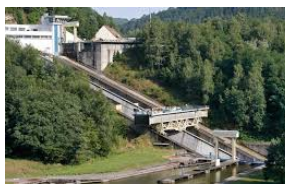
Schiffshebewerk Vallée des Eclusiers
